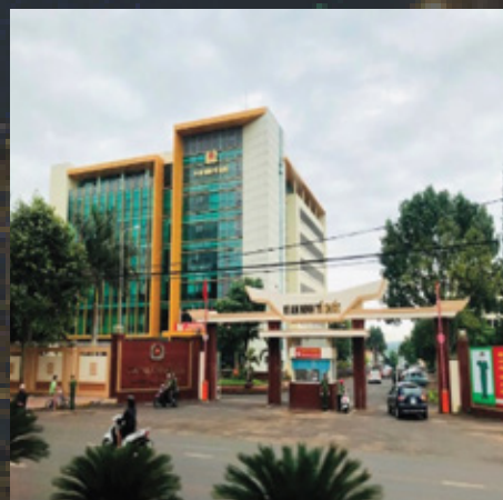
CÔNG AN TỈNH ĐẮC LẮC 1 x MPĐ 160kVA – CUMMINS (India) 1 x MPĐ 120kVA – FPT (Ý)
