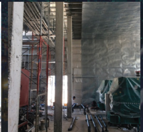
THI CÔNG, LẮP ĐẶT PHÒNG ĐẶT MPĐ CÔNG TRÌNH COCOBAY – ĐÀ NẴNG
