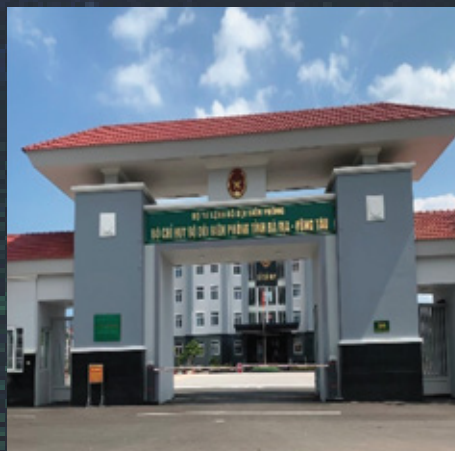
BÓ CHỈ HUY BỘ ĐỘI BIÊN PHÒNG – BRVT 1 x MPĐ 1000kVA – CUMMINS (UK) 1 x MPĐ 100kVA – COOPER (India) 3 x MPĐ 30kVA – COOPER (India)
