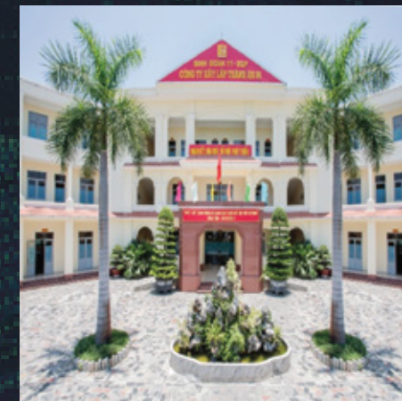
CTY CP XÂY LẮP THÀNH AN 96 – ĐÀ NẴNG 1 x MPĐ 120kVA – FPT (Ý) 1 x MPĐ 200VA – CUMMINS (China)
