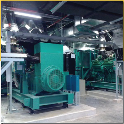
THIẾT KẾ, THI CÔNG PHÒNG MPĐ
