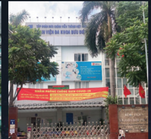
BỆNH VIỆN ĐA KHOA BƯU ĐIỆN – TP HCM MPĐ 750kVA – DOOSAN (Hàn Quốc)
