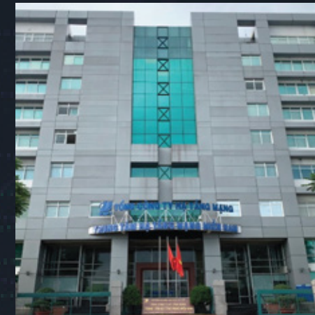
TRUNG TÂM HẠ TẦNG MẠNG MIỀN NAM 1 x MPĐ 1500kVA – PERKINS (UK) 1 x MPĐ 250VA – CUMMINS (India)
